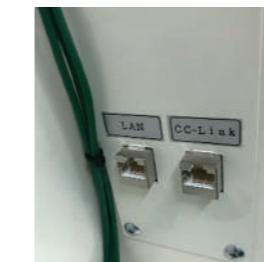
EthernetまたはCC-LINK IE Field(開発中)接続で、各種検出データ、設定内容を専用のNASへ送信し、応用が可能。
